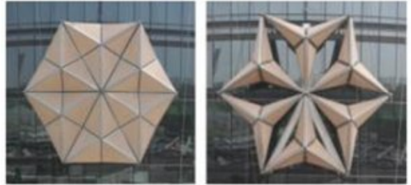
شكل (٤٣)، (٤٤) تشكيلات النسيج الخارجي تفتح وتغلق طبقا لحركة الشمس وشدة الضوء على مدار اليوم الواحد
