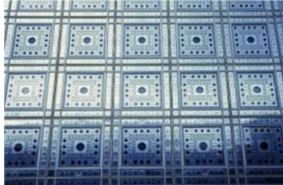
شكل ٣٣ استلهام شكل المخمرات في صورة مشربية معدنية تتحرك الكترونيا بصورة ذكية طبقا لشدة الضوء الساقط عليها لتفتح وتغلق مثل الكاميرا ومن خلال كمبيوتر مركزي .
